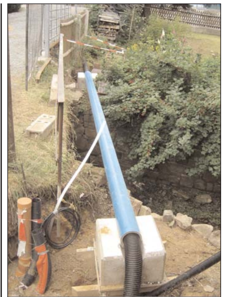
Die Querung des Dorfbaches mittels einer Druckleitung ist montiert
