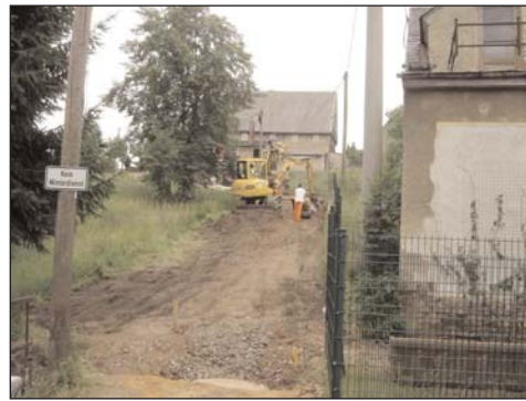
Etwa 50 m Kanal sind im Weg zur Köthensdorfer Straße bereits verlegt
