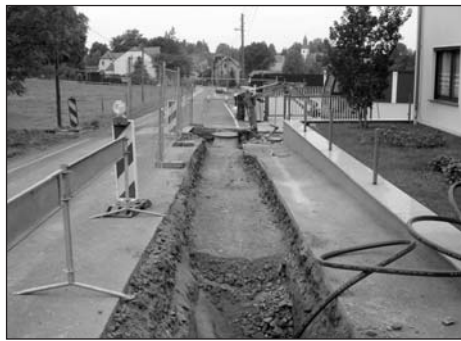
Aufgrabung in Höhe Köthensdorfer Straße 7 am 23.09.2011
