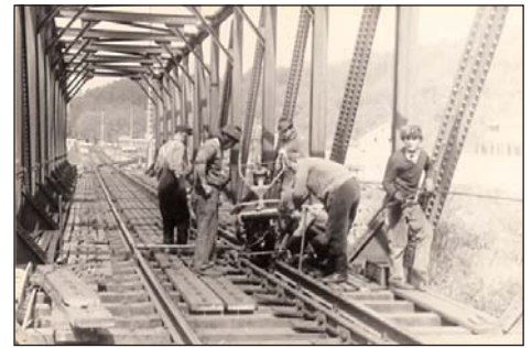
Gleisbauarbeiten Brücke Mohsdorf
